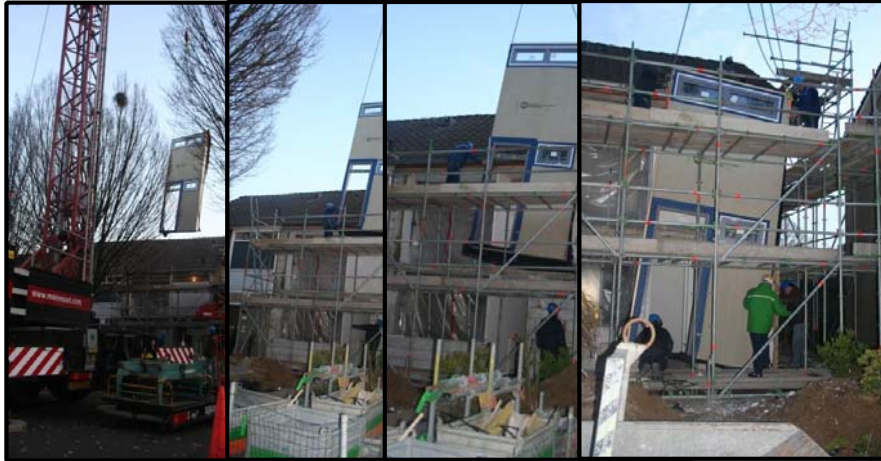
Plaatsen houtskeletbouw gevelementen VOORGEVEL
