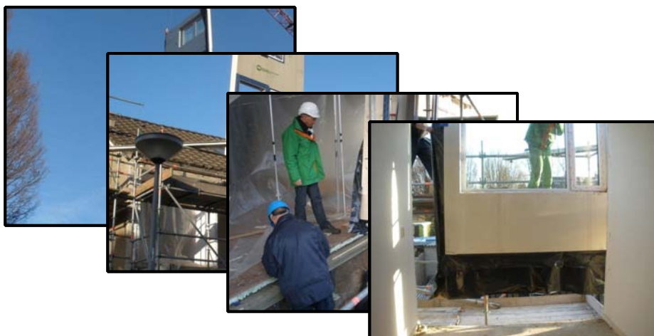
Plaatsen houtskelbouw gevelelementen ACHTERGEVEL
