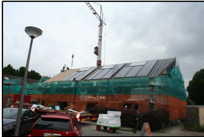
Afwerking zink en dakranden
